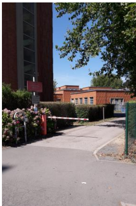
D : Entrée parking du bâtiment de recherche
